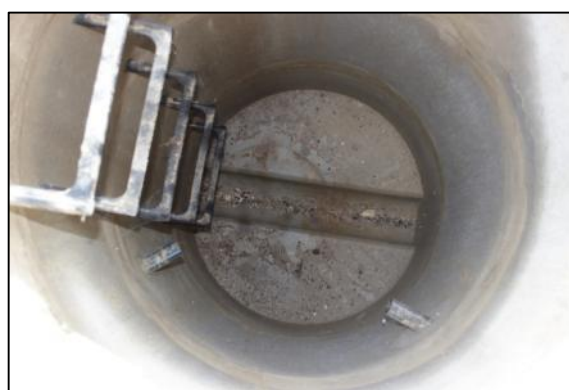
Betonakna a Kálvária-domb utcába
